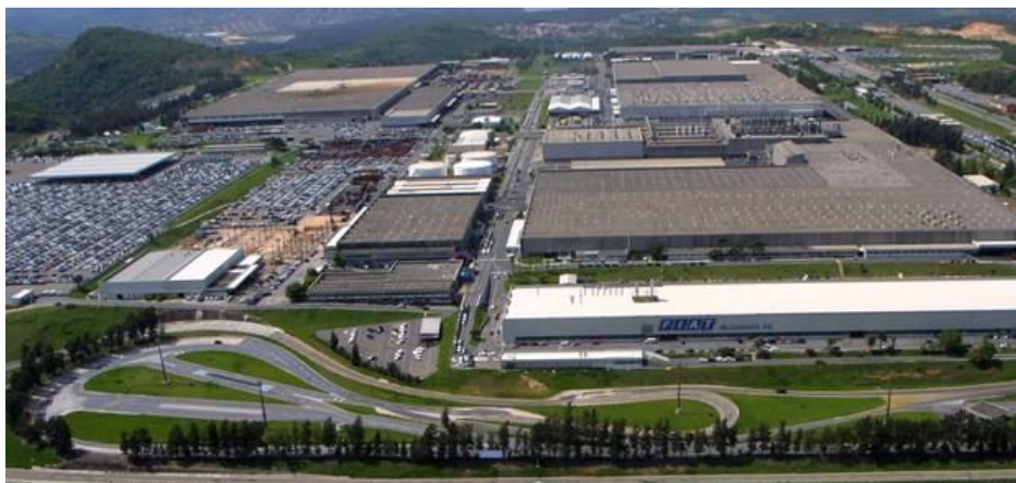
Figura 1: galpões e prédios do complexo industrial em Betim. Fonte: website “Carplace”.
