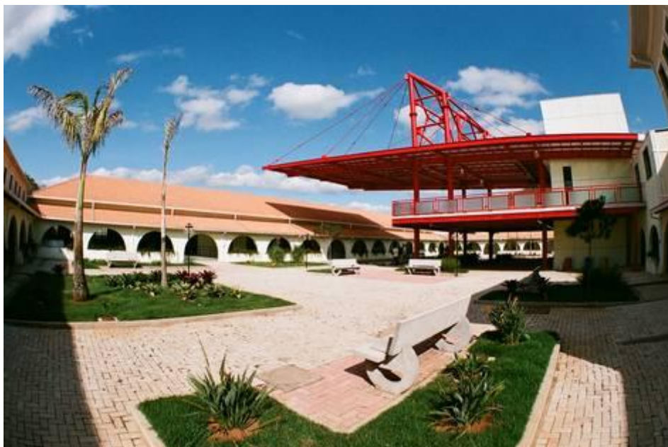
Figura 1 - Instalações do TecnoParq. Fonte: Site do CENTEV/UFV
